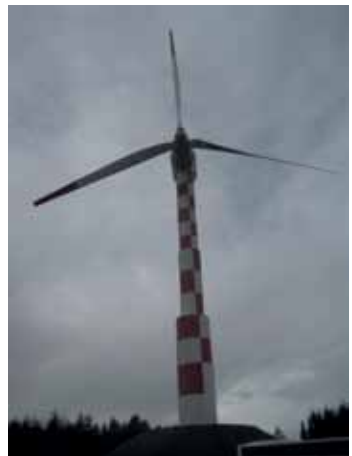
Tvind-windturbine produceert sinds 1978 nog steeds elektriciteit. (Ecopower)
